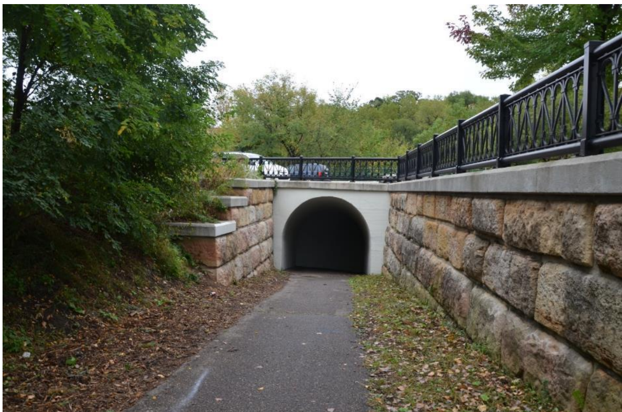
Tunneln ner till parken går under Drewry Lane
