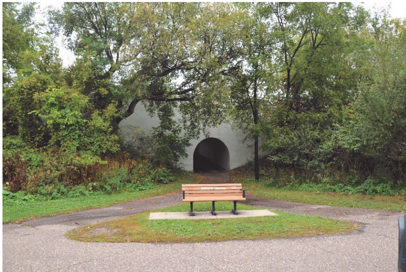
Tunneln som leder upp till Drewry Lane.
